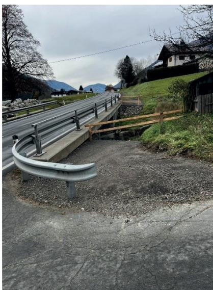
Bei der Stallerbachbrücke neben den neuen Parkplätzen wurde das alte, kaputte Brückengeländer entfernt, und durch ein neues, an der Oberseite verbreitetes Geländer ersetzt - eine Erleichterung für das Befahren mit dem LKW!
